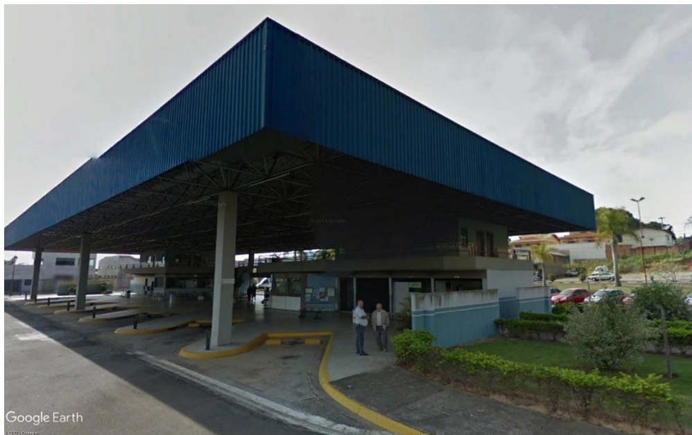
Figura 4 – Terminal Rodoviário de Cerquillo
