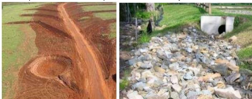
Figura 5-8. Exemplo de bacia de retenção (a) e de bacia de enrocamento (b).
