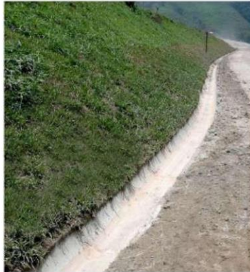
Figura 5-4. Exemplo de canaletas de concreto tipo meia-cana.
