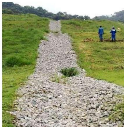
Figura 5-5. Exemplo de descida hidráulica em geocélula preenchida por pedras.
