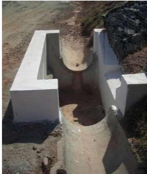
**Figura 5-6. Exemplo de caixa de passagem Tipo 1 a jusante de descida hidráulica, entre canaletas e tubos de concreto.**
