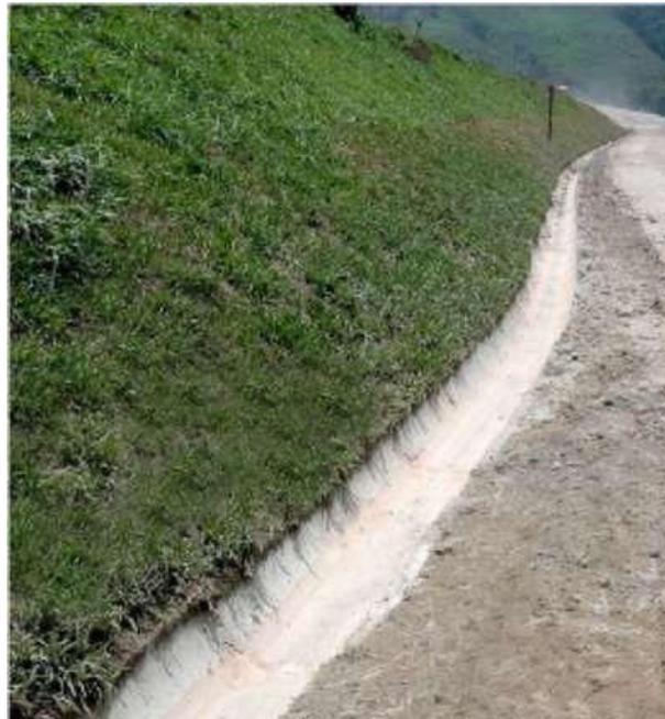
**Figura 5-4. Exemplo de canaletas de concreto tipo meia-cana.**
