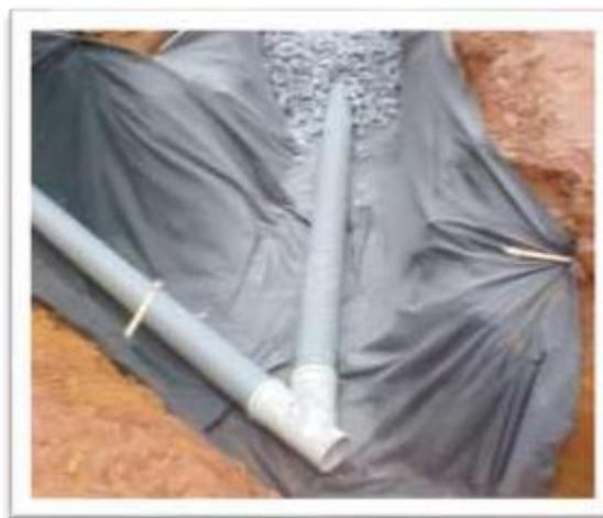
**Figura 5-3– Exemplo de drenagem de base de águas limpas.**
